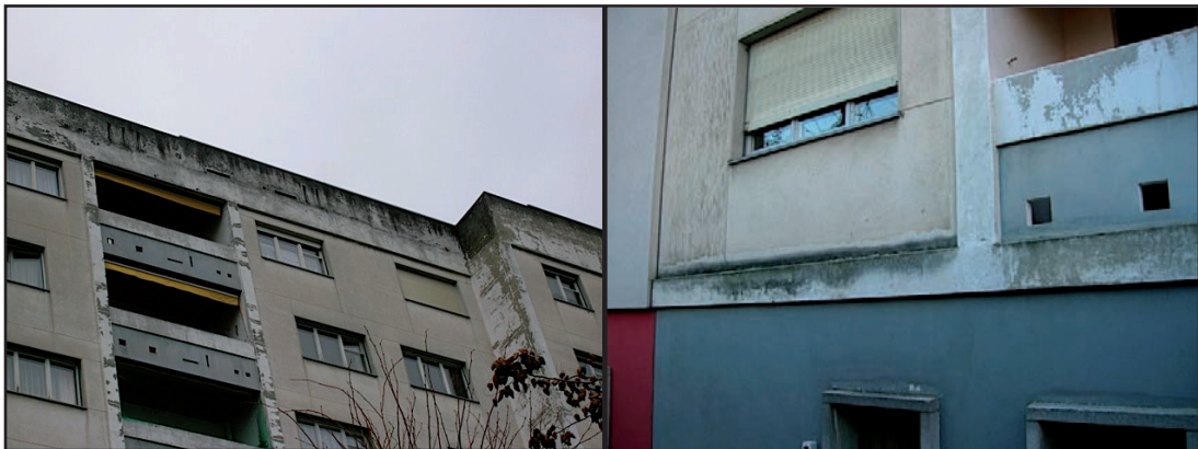
Les bâtiments ne sont pas tous rénovés à Florissant
