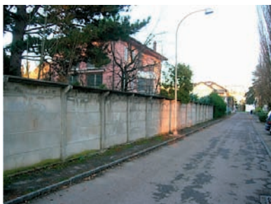
Avenue de Florissant, au nord, le périmètre du plan de quartier est clairement délimité par une barrière physique (mur, haies)
