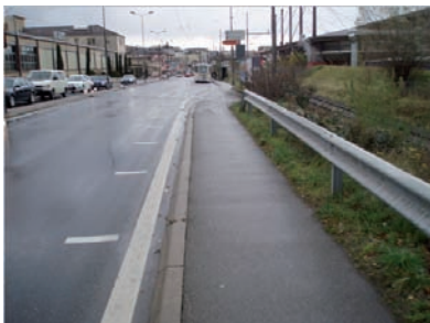
Route de Lausanne, au sud du quartier
