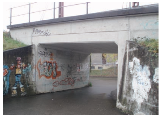
Seul passage sous-voie entre Florissant et Malley
