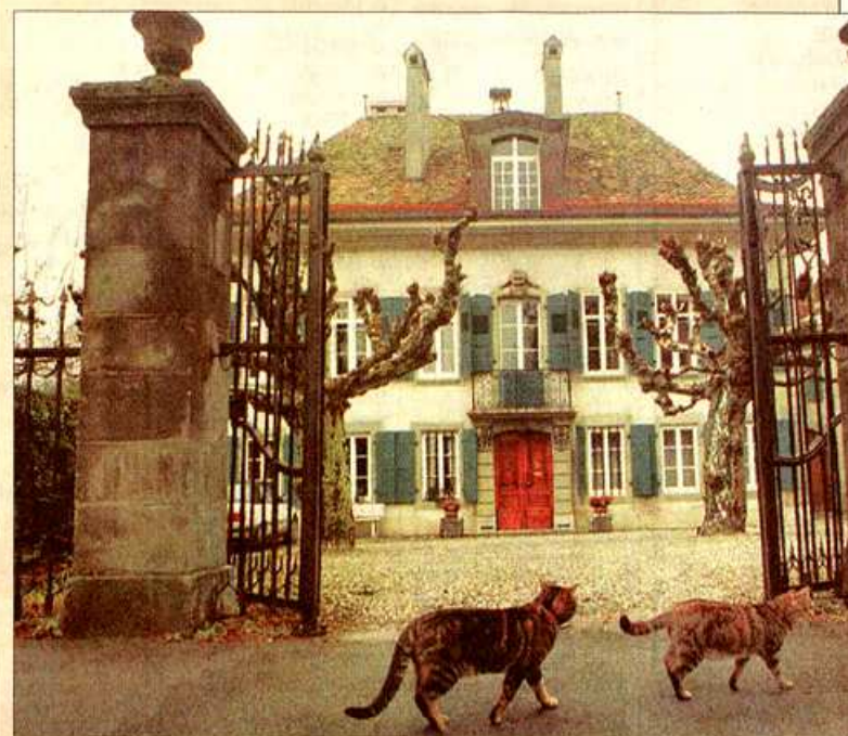
Entièrement rénové pendant la deuxième moitié du XVIII e siècle, le château comprend des éléments plus vieux, datant du XVII e siècle.
